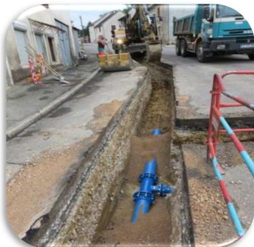
**Eau – Assainissement :** Remplacement d'une partie conséquente du réseau d'eau de Mantoche et d'une centaine de branchements plomb.
