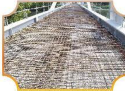
Ferrailage et bétonnage du tablier.
