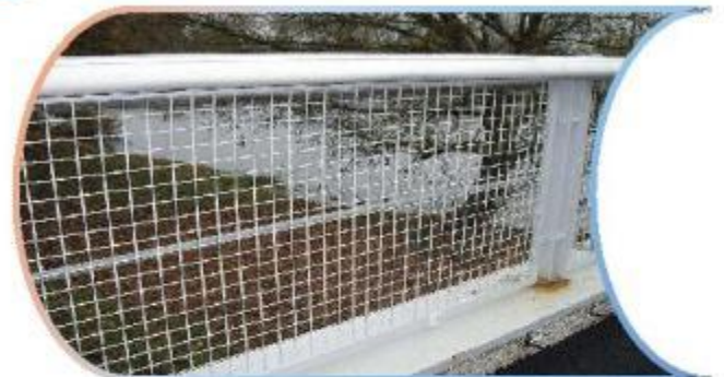
Pose des garde-corps
