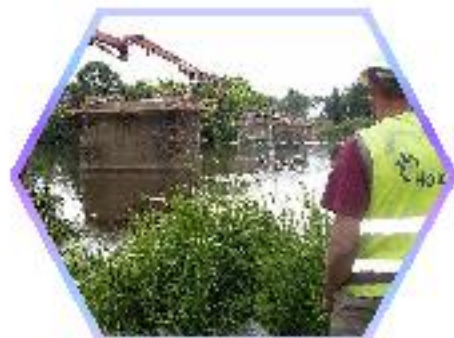
Bétonnage des piles et culées
