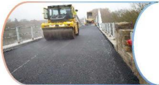
Pose du revêtement en tarmacadam.
