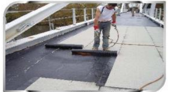
Pose de l'étanchéité. Aménagements de la chaussée aux abords de l'ouvrage.
