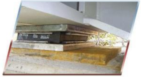
Lançage le 28/8 et mise sur appuis définitifs de l'ouvrage
