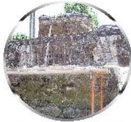
Préparation des piles, ferrailage
