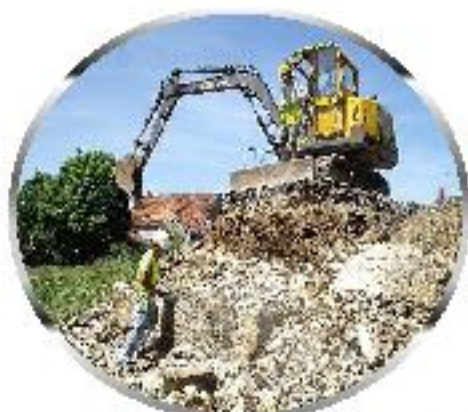
Démolition des anciennes culées
