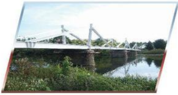
Fin du montage, soudures, peinture.
