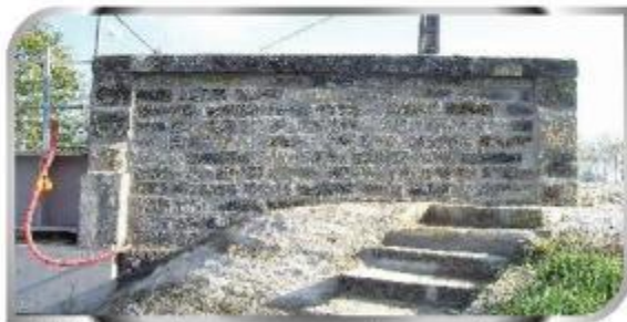
Finitions des maçonneries, remises en état des rives, Nettoyage des piles. Reprise de soudures.
