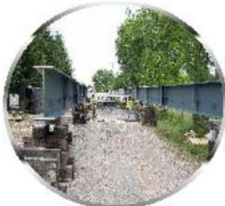
Début du chantier de montage côté rive gauche
