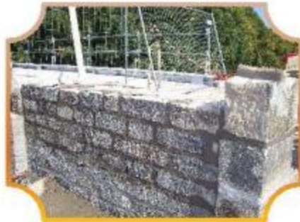
Confection des maçonneries: murs garde-grève, parapets et abords.
