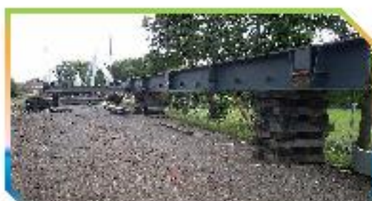
Montage de la 2ème tranche (60 mètres) à partir du 18/7
