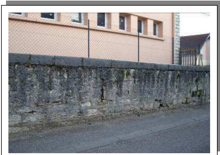
Rue des Boiges : réfection du mur de soutènement de l'école 13 864€ H.T (Subvention : 65%)
